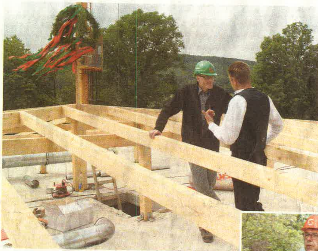
Bauleiter Jörg Meier (l.) und Zimmermann Jörg Kettler auf dem Dach des Neubaus. Im Hintergrund weht der Richtkranz.
